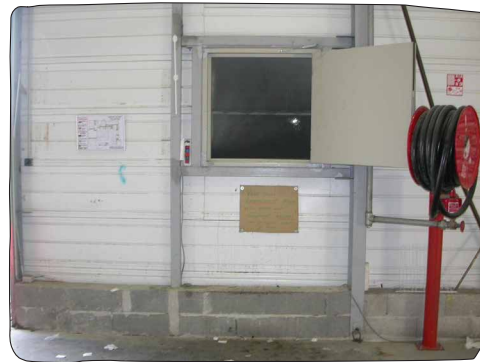
Vidage des déchets depuis l'intérieur d'un bâtiment
