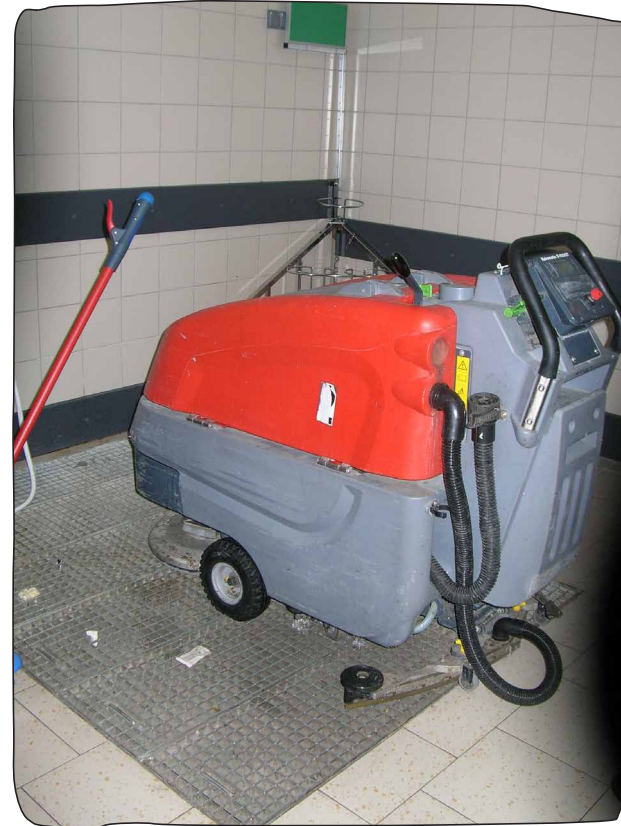
Aire de rangement d'une autolaveuse avec rétention intégrée dans le sol
