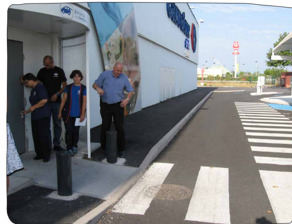
Protection physique en sortie du drive
