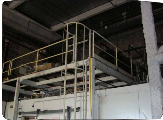
Plateforme de travail équipée d'une protection collective périphérique
