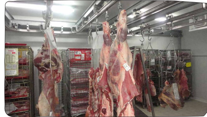
Réseau aérien de transfert des carcasses
