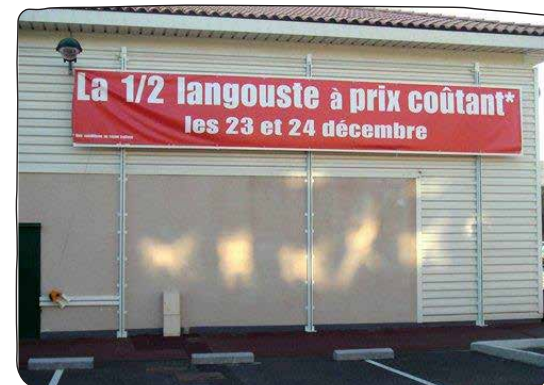
Support de banderole mobile pour mise en place depuis le sol
